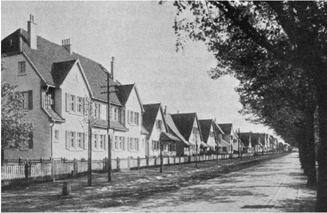
Bauverein zu Hamburg, Einzelwohnhäuser, Kolonie in Fuhlsbüttel, 1908/09. Aus: Hamburg und seine Bauten , 1914, Bd. 1, S. 584
