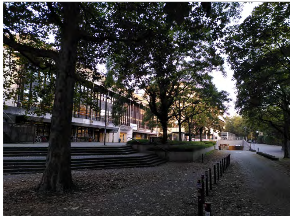
Abb. 6: Vorplatz vor dem Hauptgebäude der SUB (Eigene Aufnahme)
