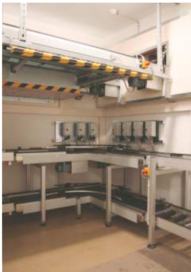
Die neue Buchkorbförderanlage
